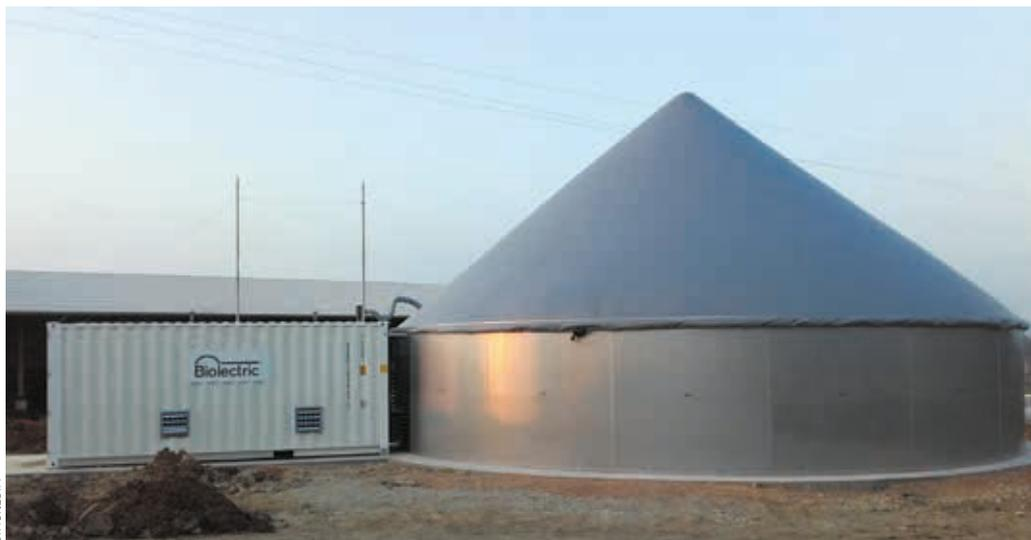
**Bioelectric est une Start Up belge créée en 2009. Elle a conçu et installé plus de 260 unités dans une dizaine de pays européens. Une installation compacte et rapide à construire :** des pompes automatiques pour l'apport de fumier et de déchets résiduels ; un digesteur en acier inoxydable ; un mixeur ; un dôme gazeux à membrane double ; un seul conteneur pour l'installation de la pompe locale ; le moteur à combustion ; le générateur et le panneau de commande général.
